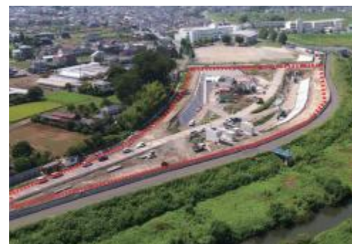
川崎調整池工事中の様子
