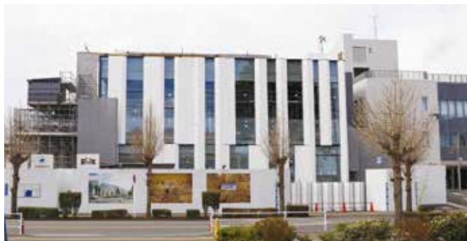
ステラ・イーストホール棟工事の様子
