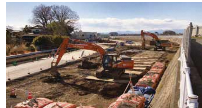
川崎調整池工事の様子
