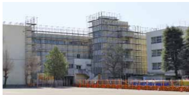
工事中の校舎
