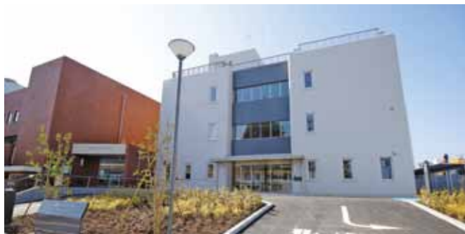
リニューアルしたステラ・イースト多目的棟
