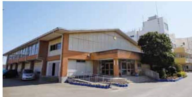
エアコン設置や改修工事が始まる体育館
